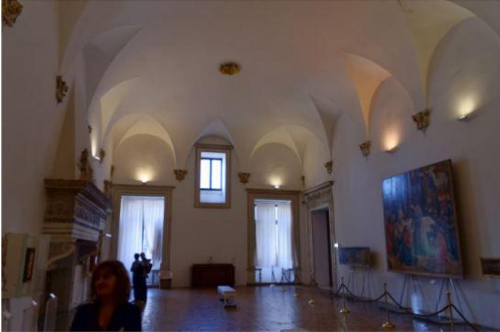
Fig. 81 : Voûtes renaissance au palais ducal d'Urbino. Les baies d'ouverture (fenêtre haute, fenêtres munies de banc) sont placées en tenant compte des points d'appui des voûtes. (Photo 331061 MH 2009).
