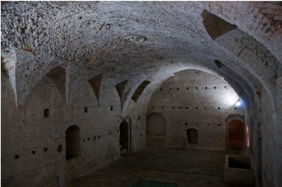
Fig. 82 : Voute surbaissée dans les sous-sols du palais ducal d'Urbino. Elles n'ont jamais été enduites, et laissent voir l'appareillage des briques. (Photo 329060 MH 2009).
