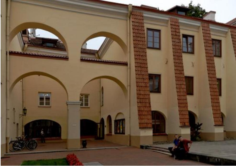
Fig. 71 : Arcs-boutants et contreforts stabilisant les bâtiments orientaux de la cour Sarbievijus. (Photo 586053 MH 2013).
