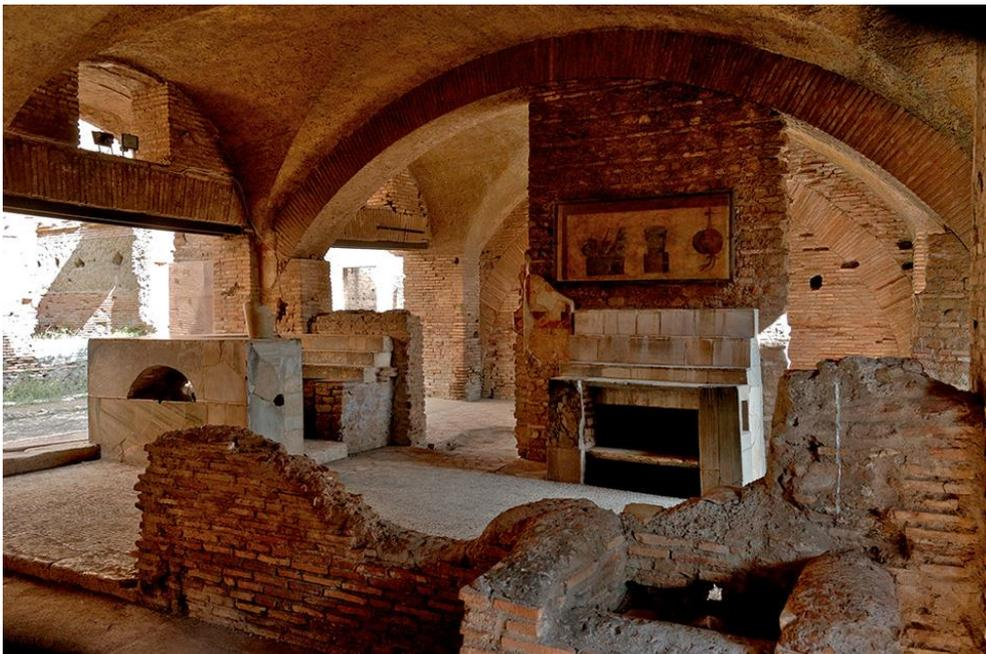
Fig. 84 : Voûte surbaissée en briques apparentes, Ostie. Époque romaine. (Photo io39011 MH 2005).
