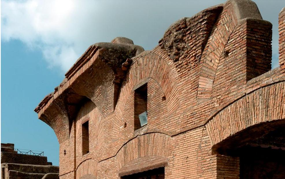
Fig. 83 : Encorbellement de briques à Ostie, port antique de Rome. L'appareillage des briques annonce celui de la Renaissance italienne. (Photo io38053 MH 2005).
