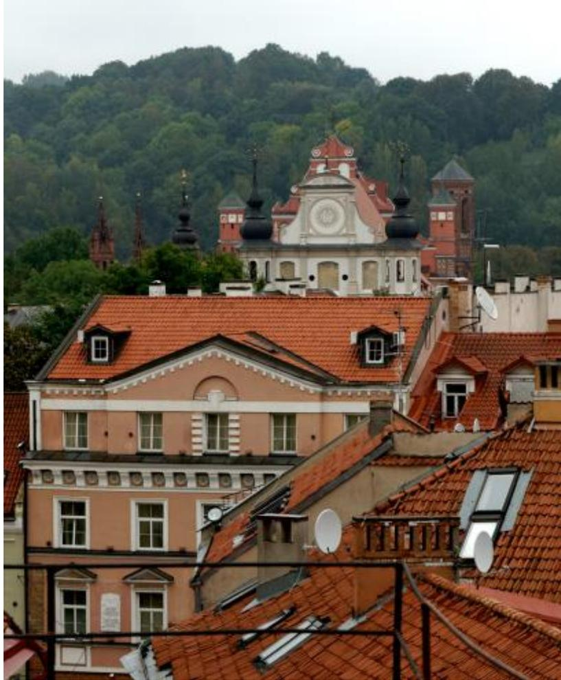
Fig. 85 : Toitures dans la ville de Vilnius: la tuile composite y domine, le métal (cuivre ou plomb) garnit les emplacements aux formes complexes. (Photo 590046 MH 2013).
