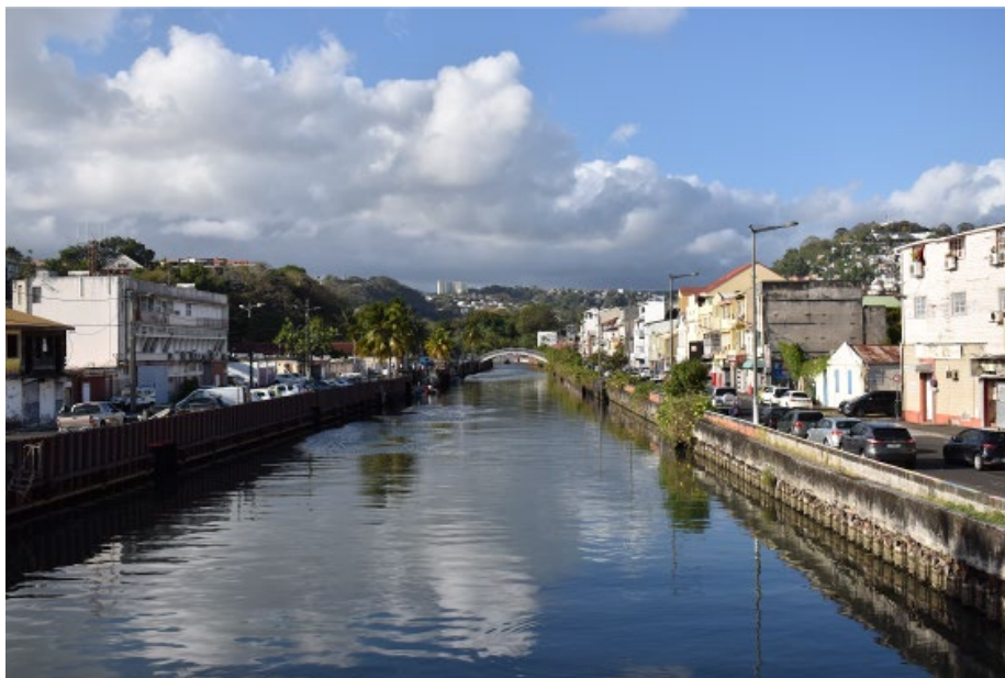
Le canal Levasor (côté terre), Fort-de-France 2022 (Photo de Fabienne Cabord)
