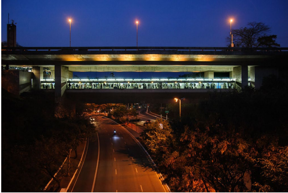
Fig. 6. Vista exterior y nocturna de la estación de Sumaré, con énfasis en el valle y la avenida Paulo VI que se encuentran bajo su estructura. 2019. Companhia Metropolitana Metrô São Paulo.
