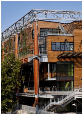
Usine de traitement des déchets d'Issy Les Moulineaux
