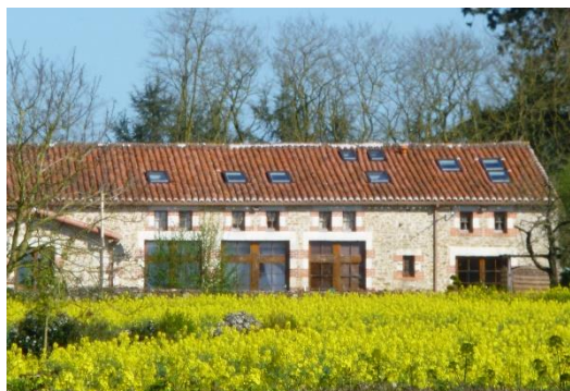
1 Salle paroissiale dite "patronage", vue côté champs, cliché AR, 2015
