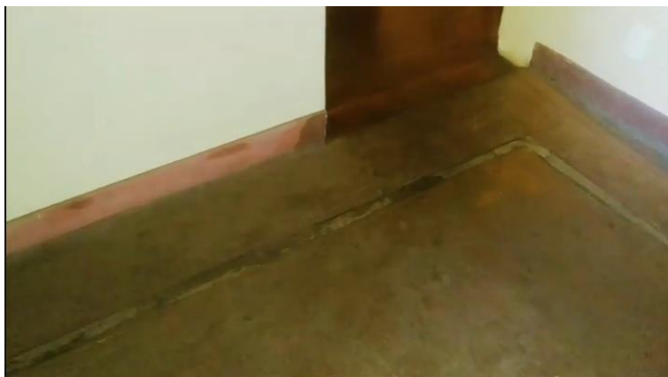
Figura 4 - detalhes do piso - foto Sinara Medeiros
