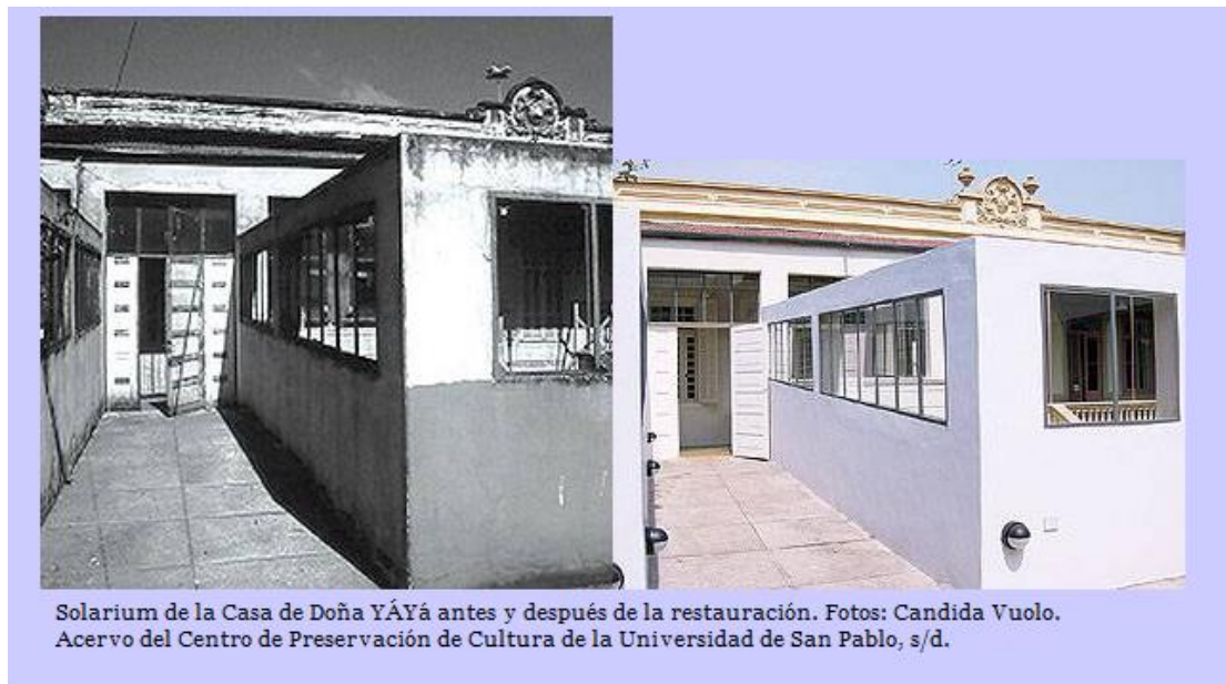
Figura 11 - Solário da Casa de Dona YáYá antes e depois da restauração. Foto: Candida Vuolo. Coleção do Centro de Preservação Cultural da Universidade de São Paulo, n/d.
