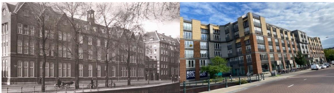
Izquierda: imagen del edificio para adultos mayores del sector social, rentas alrededor de 250 euros. Derecha: el edificio remodelado para al sector libre con rentas promedio de 1500 euros.
